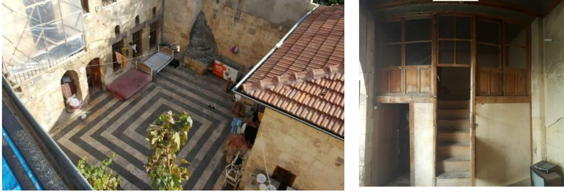
Şekil 2. Hayat (solda) ve dolap içi merdivenleri (sağda) örnekleri
