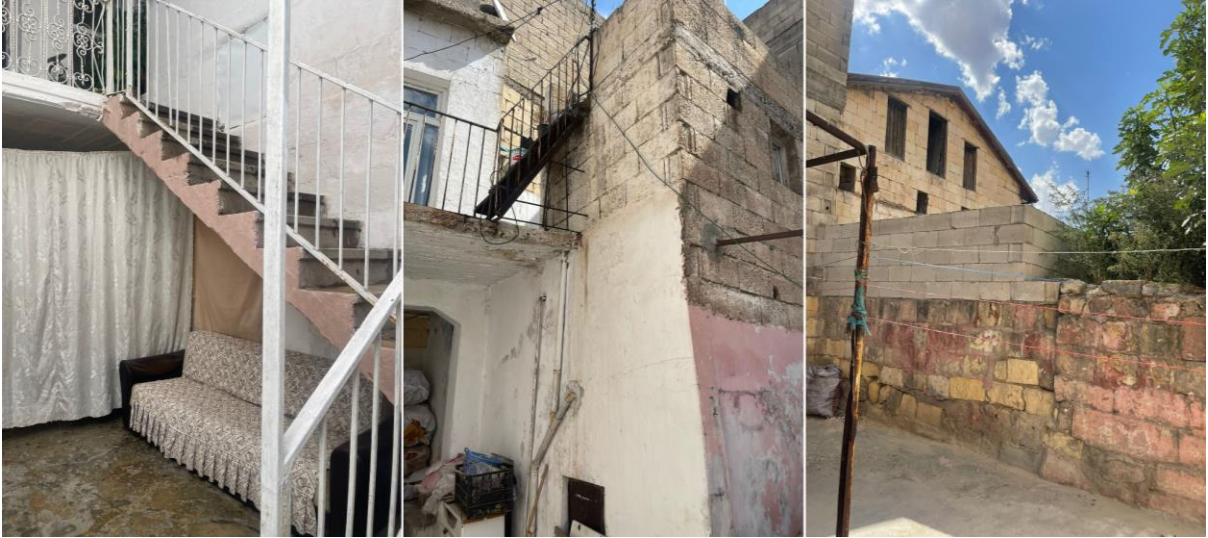
Şekil 6. Hayat içinde betonarme merdiven eklemeleri (sol, orta), hayat duvarlarına briket eklemeler (orta, sağ)
