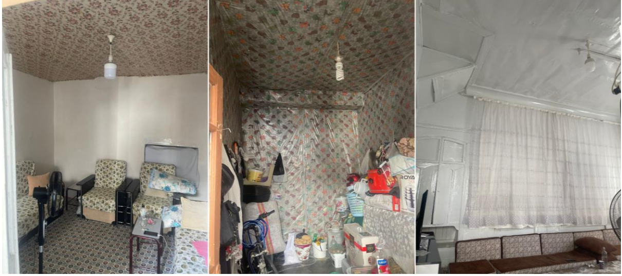
Şekil 9. Ahşap kirişlerin farklı malzemeler ile kapatılması kumaş (sol), naylon (orta), kontrplak (sağ)
