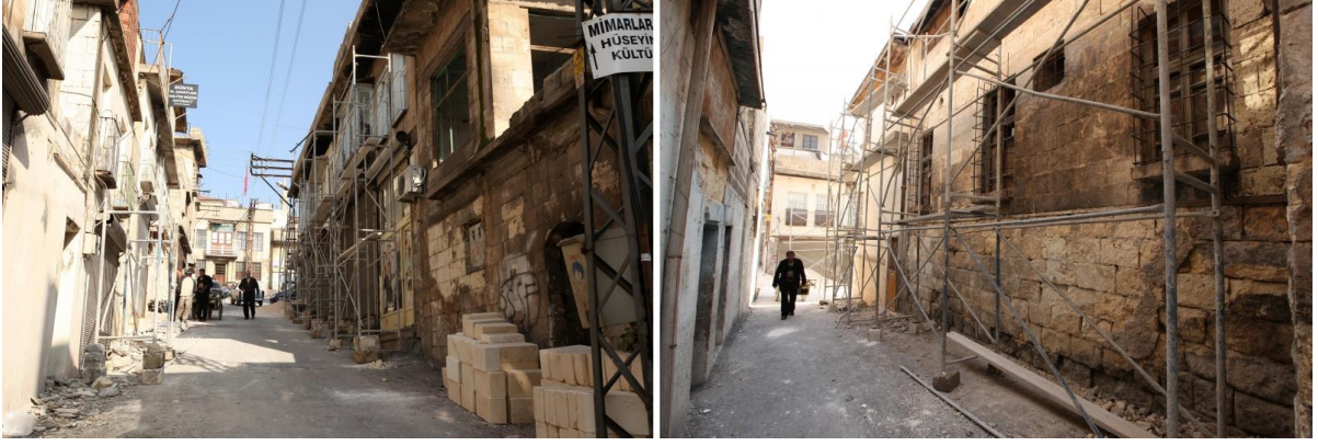
Şekil 4. Kazancı ve Köroğlu Sokaklarında Sağlıklaştırma Çalışmaları (GBB, 2011)
